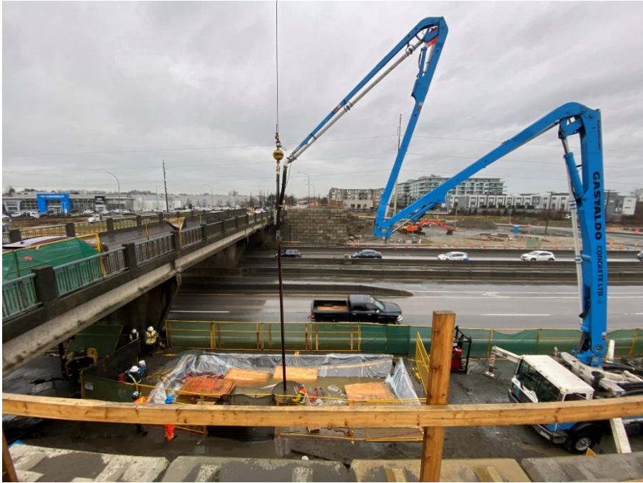
Figure 1: Tremie concrete pour for piles infill
